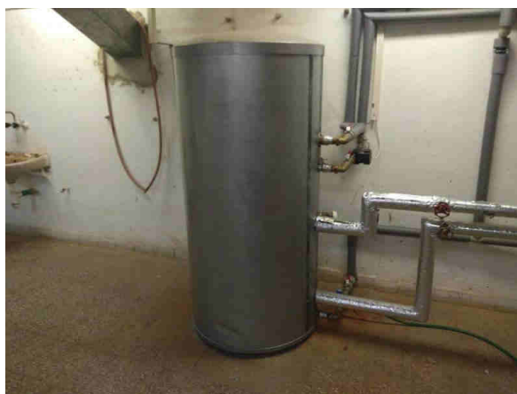
Obr. 19: Nepřímotopný zásobník na teplou vodu o objemu 600 l
