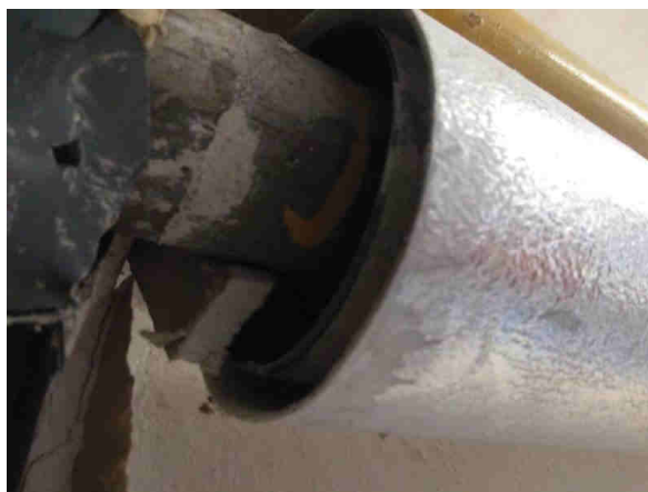
Obr. 21: Tepelná izolace rozvodů otopné soustavy
