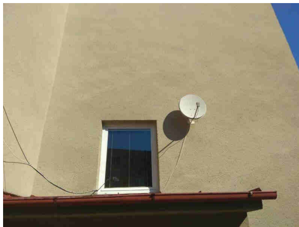
Obr. 17: Plastové okenní výplně s izolačním dvojsklem z roku 2003
