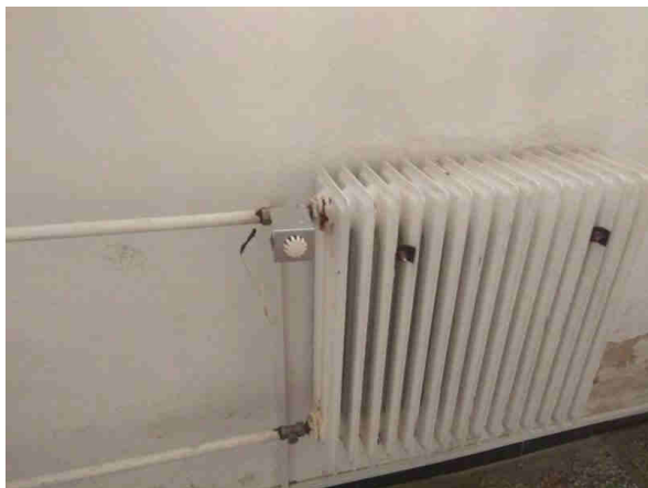
Obr. 22: Otopná soustava s termostatickými ventily
